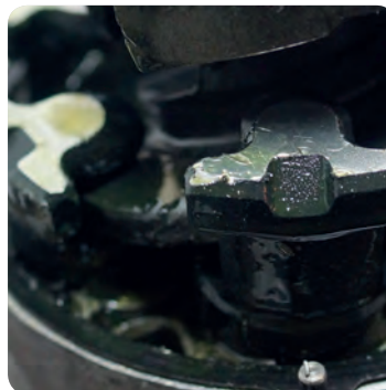
Olej zanieczyszczony środkiem uszczelniającym – widoczne zanieczyszczenia na płycie wychylnej i tłokach.
